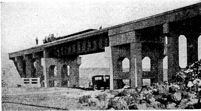
Abb. 3. Eisenbeton-Steifrahmen als Widerlager für eine schräge Bahnbrücke.
