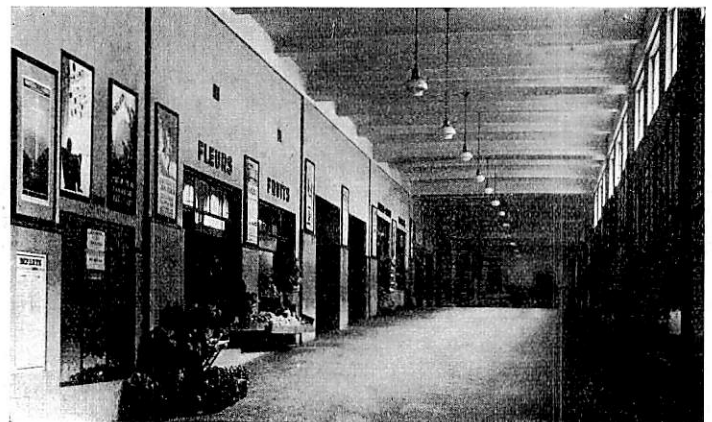
Abb. 9. Blick in die Rampe zur Personenunterführung.
