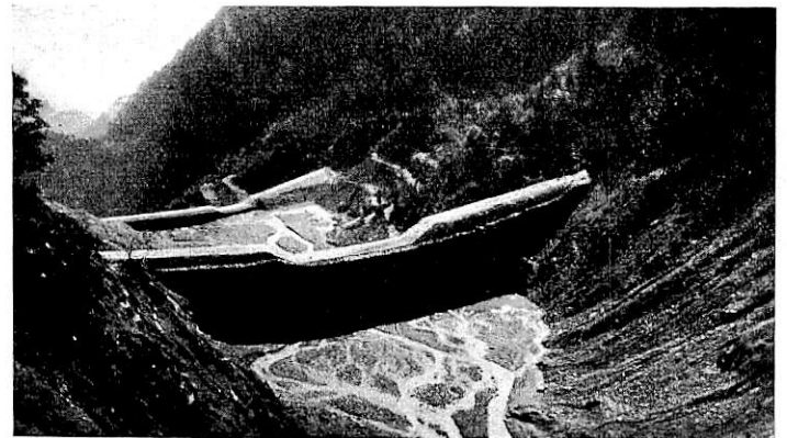
Abb. 7. Die fertigen Sperren Nr. 3 und 5. (Die Auflandung oberhalb der Mauern ist inzwischen vollständig erfolgt.)
