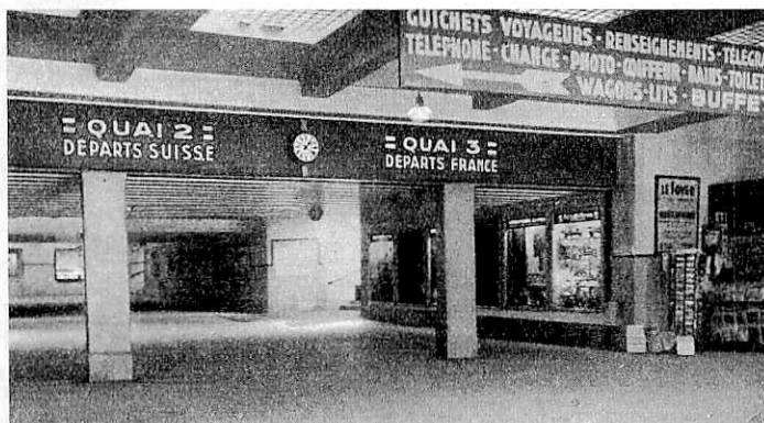
Abb. 4. Personentunnel. Einblick vom Aufnahmegebäude aus.
