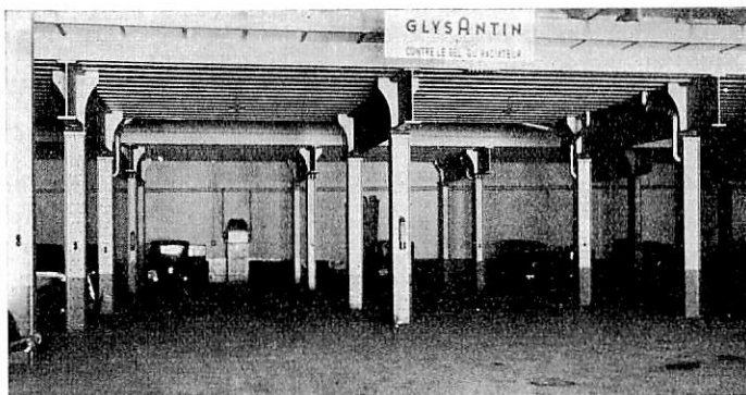
Abb. 6. Raum I (Garage), Innenansicht gegen das Aufnahmegebäude; Säulen der Bahnsteigbrücken I bis IV.
