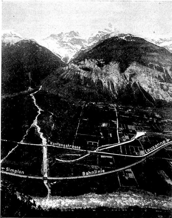
Abb. 2. Der Schuttkegel des St. Barthélemybaches im Mai 1926 (vor dem ersten großen Ausgange).
