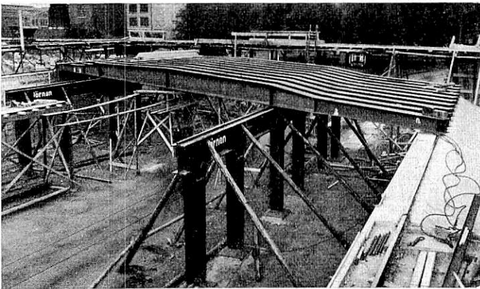
Abb. 11. Geschweißte Träger, zum Einbetonieren verlegt.
