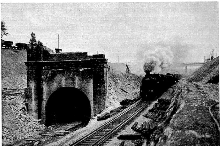
Abb. 9. Die Betriebsgleise sind aus dem Tunnel in den Umfahrungsschlitz gelegt. Das Leipziger Portal ist zur Sprengung vorbereitet.
