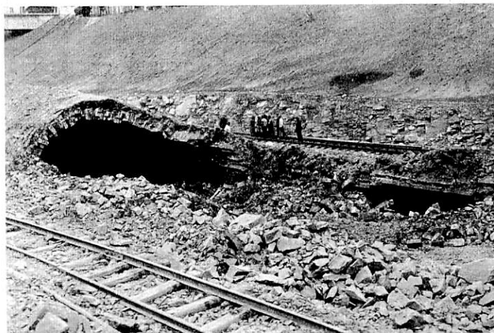
Abb. 10. Die Tunnelröhre wird gesprengt. Im Hintergrund das Umfahrgleis.
