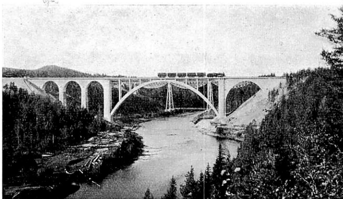
Abb. 1. Die Eisenbahnbrücke über Öre älv.
