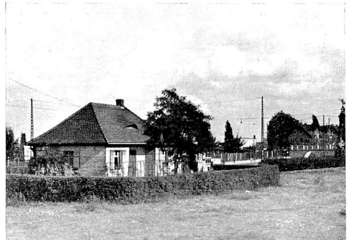
Abb. 7. Ältestes Bahnwärterhaus Deutschlands. (Bahnseite, Gleis ist entfernt.)
