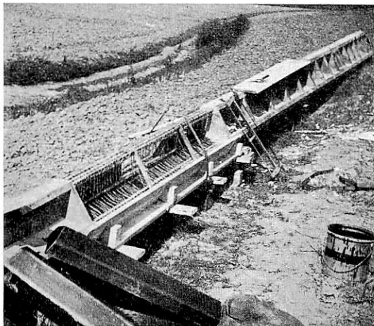
Abb. 17. Instandsetzen eines beschädigten Mastes.
