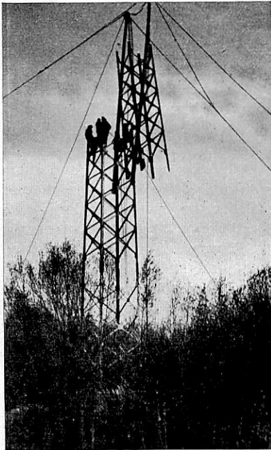
Abb. 21. Aufstocken eines Donaukreuzungsmastes.
