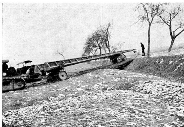
Abb. 15. Betonmastbeförderung über Brücke aus Holzschwellen.
