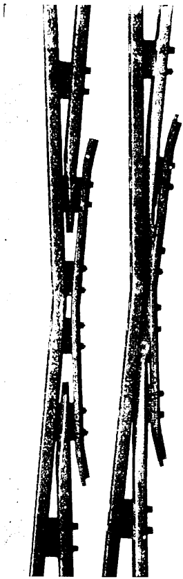
Abb. 41. Doppelherzstücke Form 8a alte Bauart und aufgearbeitet.
