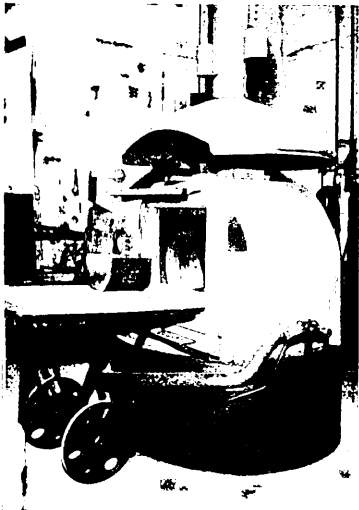
Abb. 36. Ofenretorte mit Ölbrenner.
