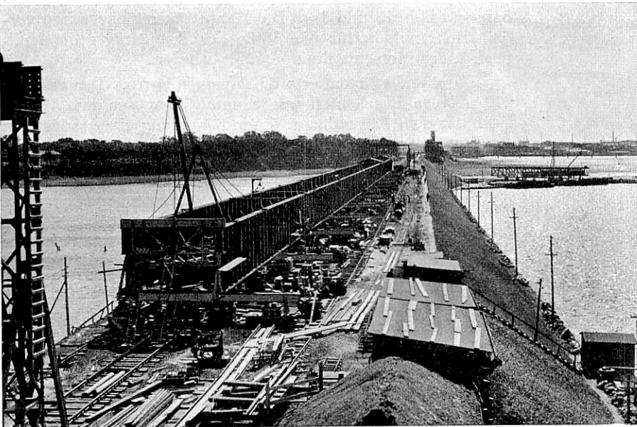
Abb. 15. Strelasundbrücke. Montage einer 270 m langen Hälfte der Eisenbahnbrücke auf der Dammkrone am Widerlager.
