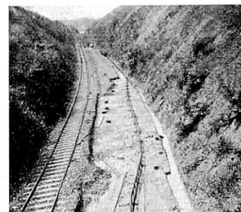
Abb. 14 b. Freigelegte Unterbaukrone.
