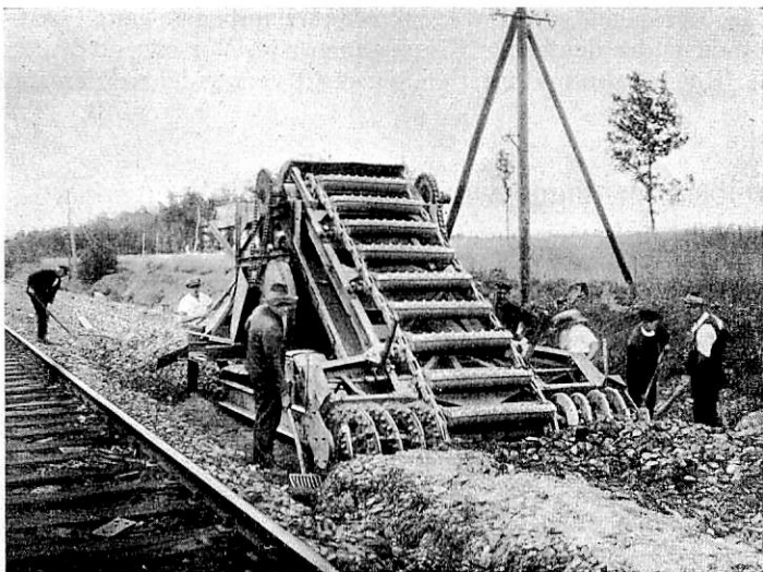
Abb. 13. Bettungsreinigungsmaschine, Bauart Hannover.
