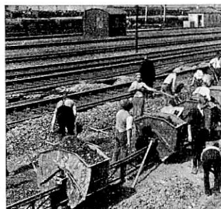
Abb. 14 a. Beladen der Förderwagen auf der Strecke.
