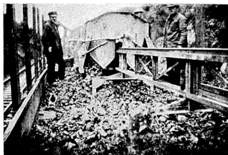
Abb. 14 e. Förderwagen auf Bauzug entladen.
