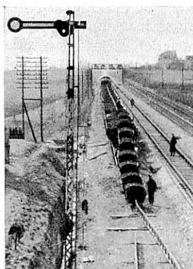
Abb. 14 c. Ausweiche vor dem Bauzug.
