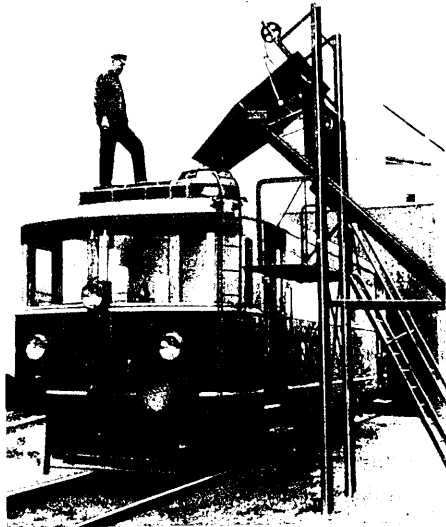
Abb. 2. Bekohlungseinrichtung für Anthrazitgas-Triebwagen.
