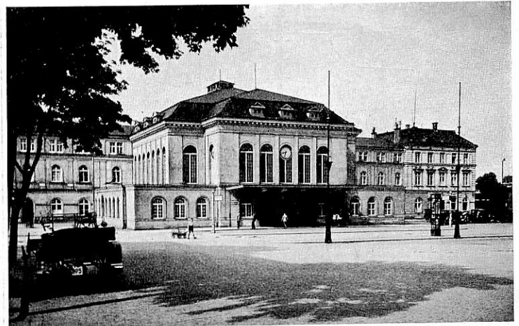
Abb. 20. Empfangsgebäude Bautzen nach dem Umbau.
