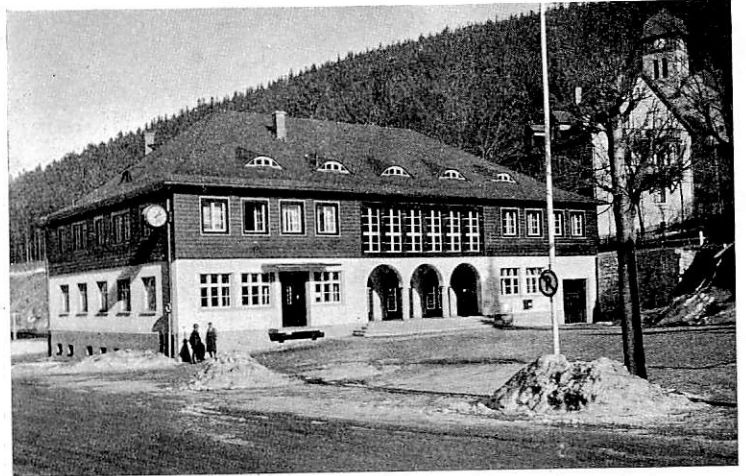
Abb. 19. Empfangsgebäude Kurort Kipsdorf.
