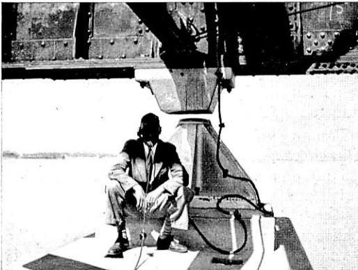
Abb. 13. Absetzen eines Kragträgers auf das feste Auflager.
