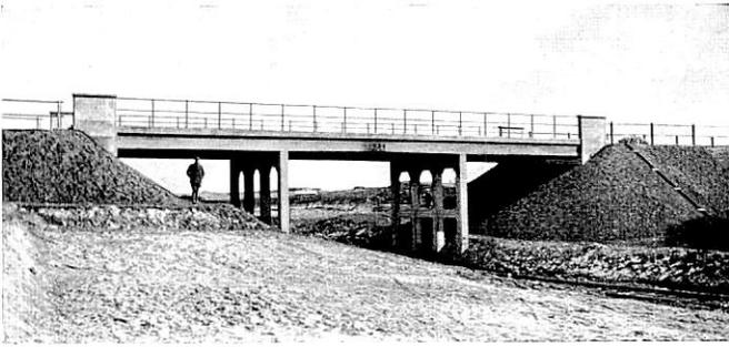
Abb. 2. 7 m Überführung eines öffentlichen Nebenweges über die Strecke: Struer—Thisted in Nordjütland.
