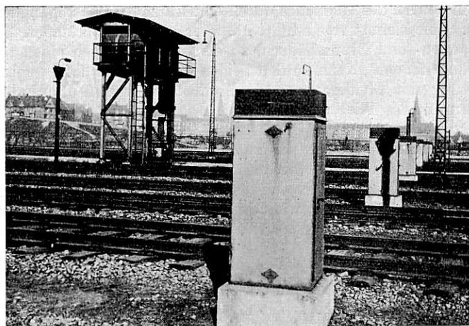
Abb. 10. Hochbehälter und Zapfstellen für Treibstoff.
