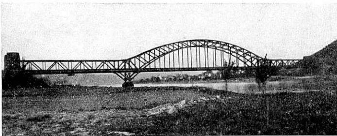
Abb. 3. Rheinbrücke bei Remagen, erbaut 1916; St. W. 84 m, 156 m, 84 m.
