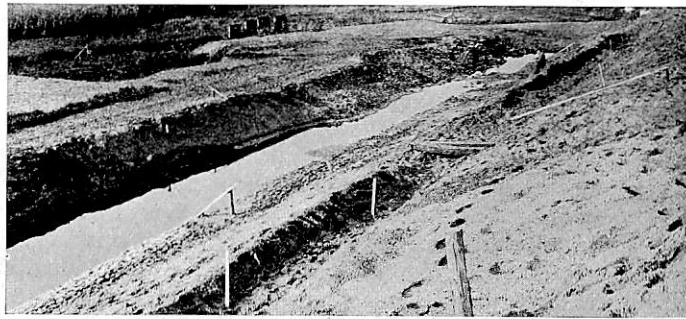
Abb. 13. Entlastungsgraben am Fuße des gesenkten Dammes auf moorigem Schlickboden.
