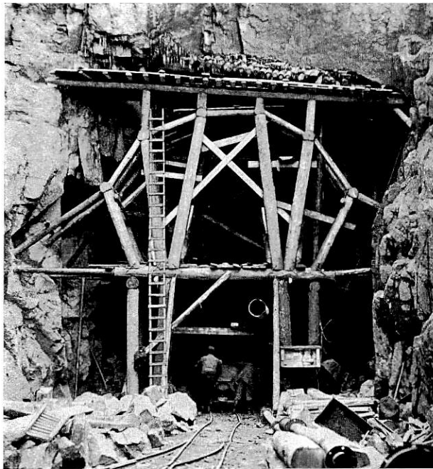
Abb. D5. Zimmerung im Vollausbuch.
