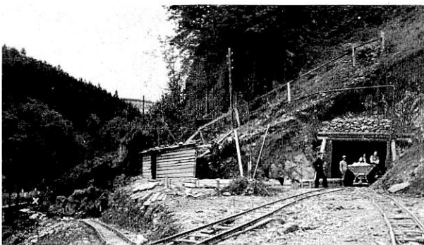
Abb. B3. Nordöstlicher Eingang des Sohlstollens und Platz X der Baustelleneinrichtung.
