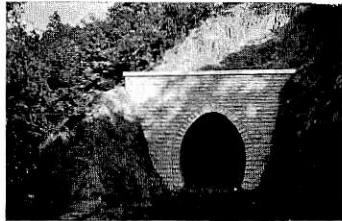
Abb. A 16. Südliches Tor des Köttewitzer Tunnels.
