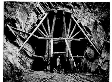
Abb. A 6. Auszimmerung des Vollausschlags.
