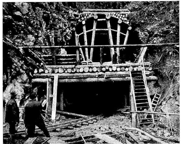
Abb. B 6. Schutzbühne gegen Felssturz.
