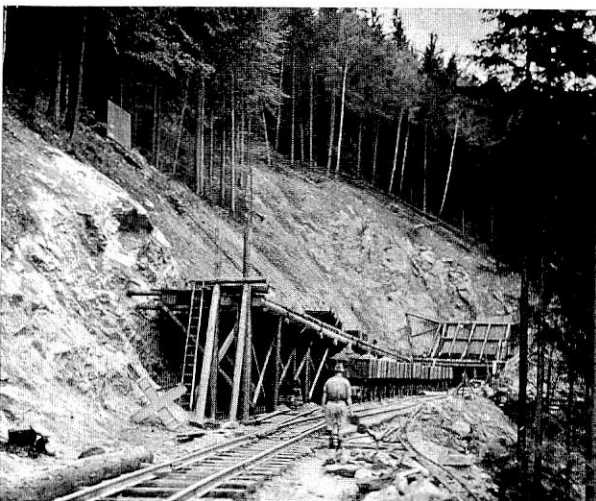
Abb. C5. Massenumladebühne.
