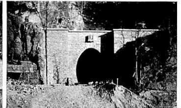
Abb. B11. Westliches Tunnel tor.
