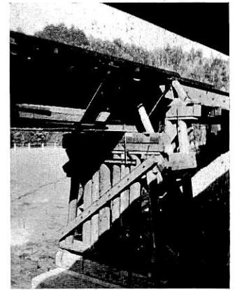
Abb. 5. Schmalspurige Hilfsbrücke für den Bau der Brücke 70.
