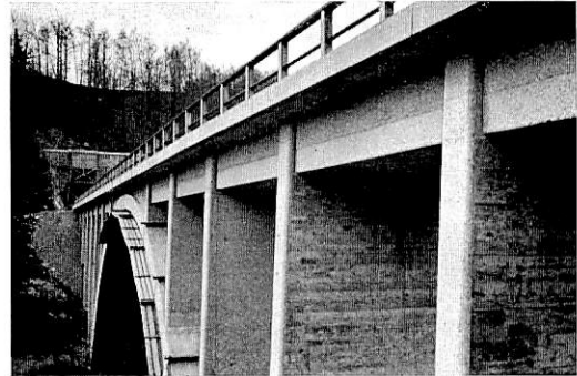
Abb. 3. Brücke bei Köttewitz. Gesimsband.
