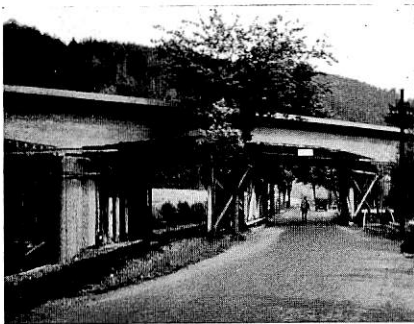
Abb. 1. Talbrücke 54 bei Bärenhecke; in der 3. Öffnung Kreuzung der Schmalspurbahn und der Reichsstraße.
