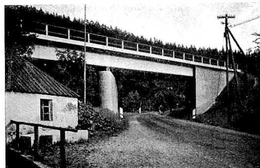
Abb. 9. Talbrücke bei der Büttnermühle.
