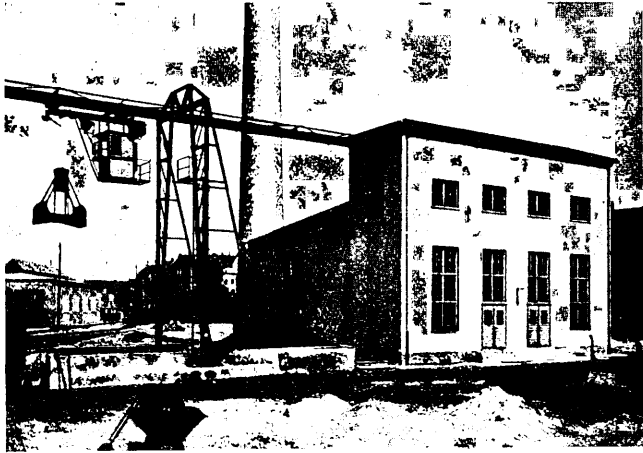
Abb. 1. Außenansicht des Heizwerks mit Bekohlungsanlage.
