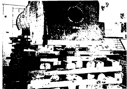
Abb. 8. Hochheben des Kessels mit Hilfe eines Schwellenstapels.
