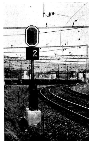
Abb. 6. Einfahrtsignal mit Gleisnummernsignal.
