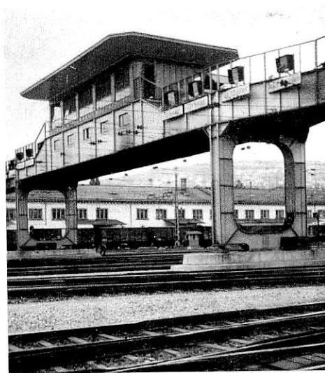
Abb. 1. Ansicht der Brücke mit dem neuen Befehlsstellwerk.
