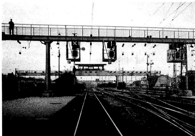
Abb. 5. Brücke der GleisAusfahrtsignale mit darüberbefindlichen Rangierverbotsignalen (dahinter die alten Ausfahrtsignale).
