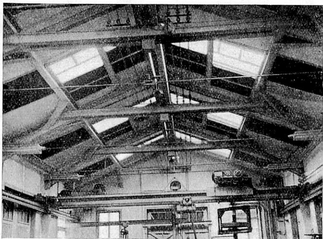
Bild 4. Abdunkelung von Hallenoberlichtern durch Holzfaserhartplatten.
