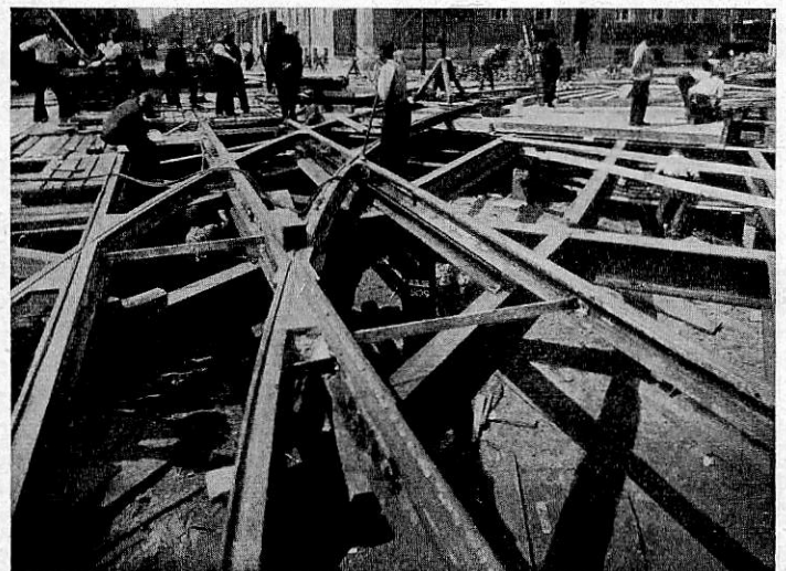
Bild 20. Fahrbahnausbildung mit Straßenbahngleisen bei sehr beschränkter Bauhöhe.
