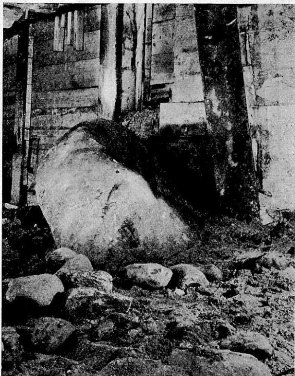
Bild 36. Verbogener Rammträger.
