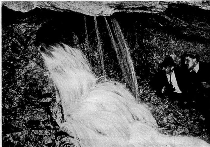
Bild 3. Wassereinbruch vor Ort des Sohlstollens der Nordseite des Tauerntunnels (Stollenmeter 5949).
