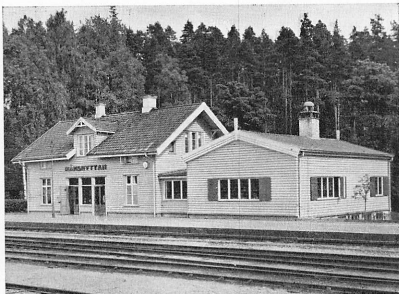
Rämshyttans stationshus efter ombyggnaden.
