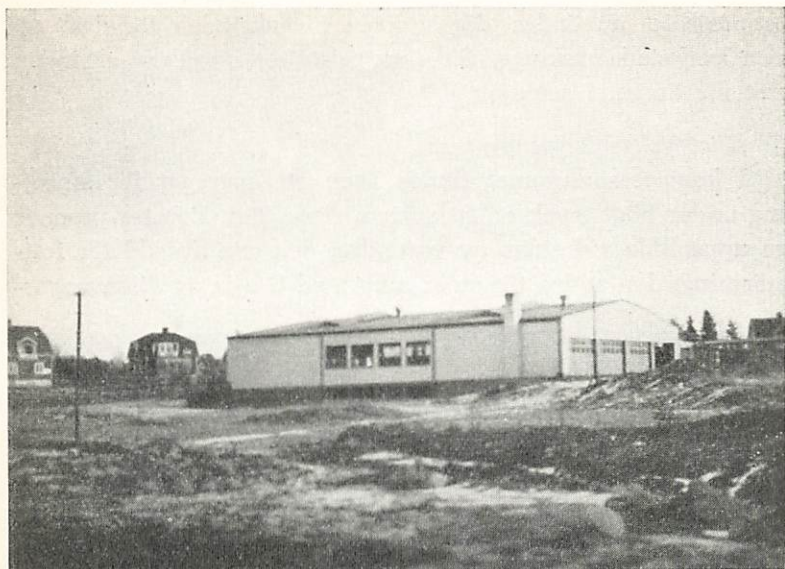
Fig. 11. Garaget från norr. Inkörning till souterrängvåningen längst till vänster.
