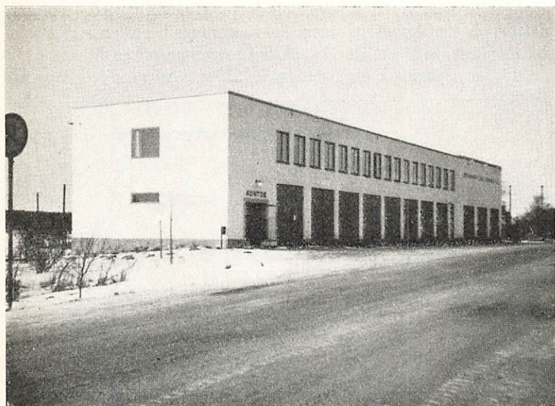
Fig. 28. Kontors- och verkstadsbyggnaden.
