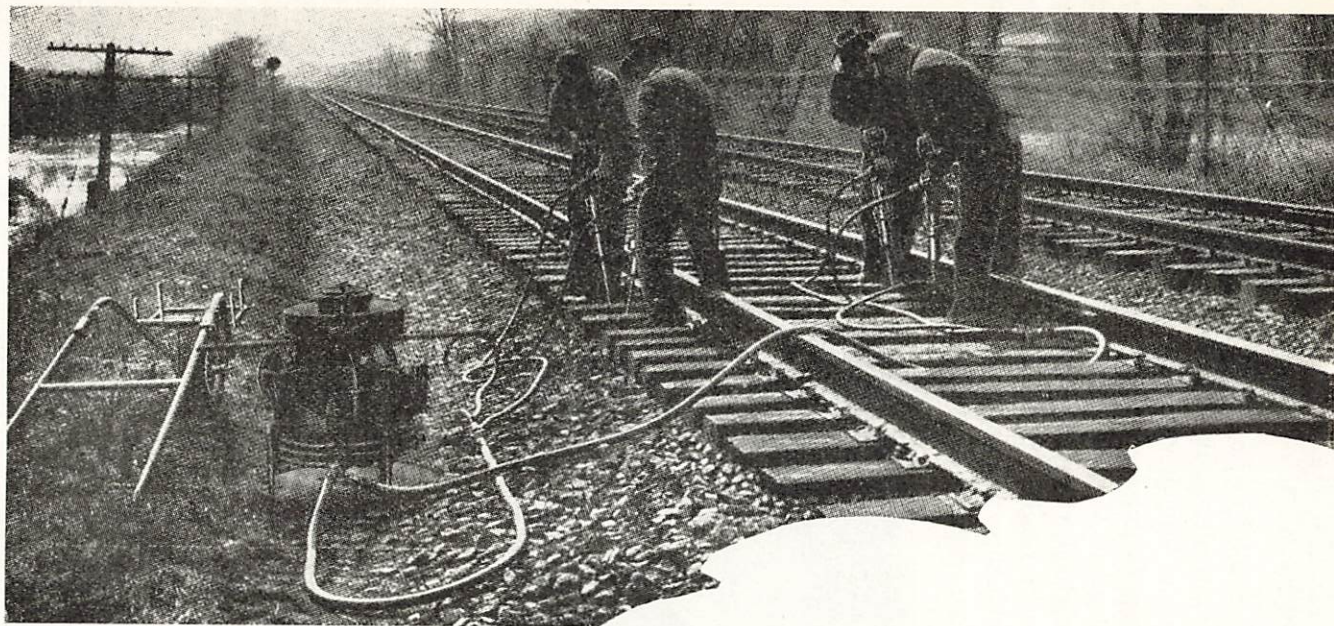
Fig. 3. Sliperstoppning med pneumatisk stoppmaskin. Tillverkare är Ingersoll-Rand, USA.
