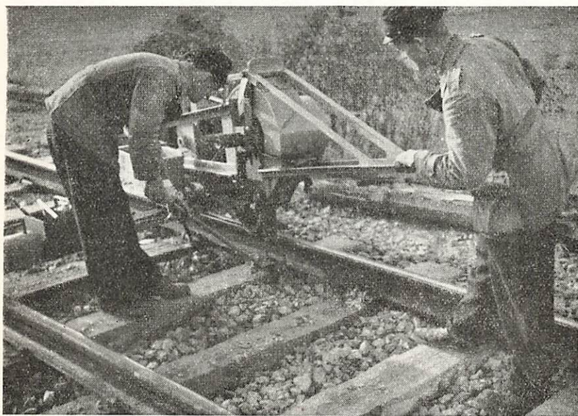
Fig. 5. Spikning med spikmaskin av amerikansk tillverkning.
