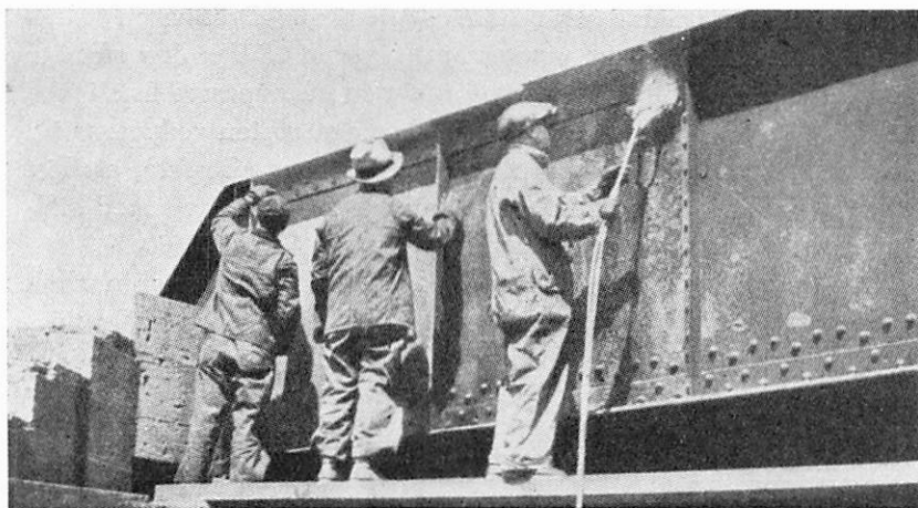
Bild nr 11. Flambehandling och målning av järnvägsbro i USA.
