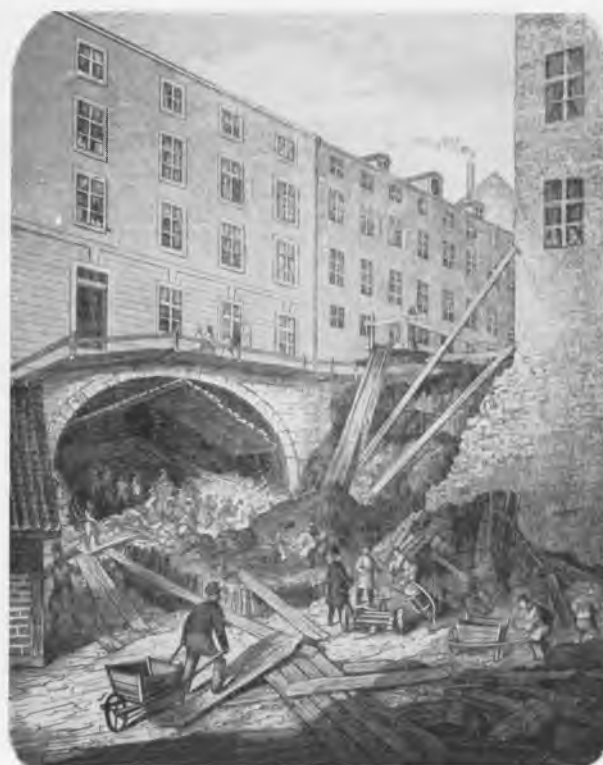
Norra inslaget till tunneln under Södermalm.
