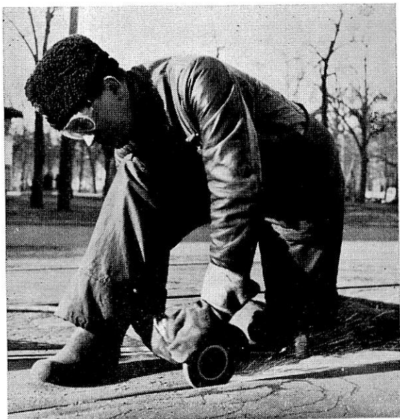
Så här skall en arbetare vara utrustad vid smörgling av spår.
