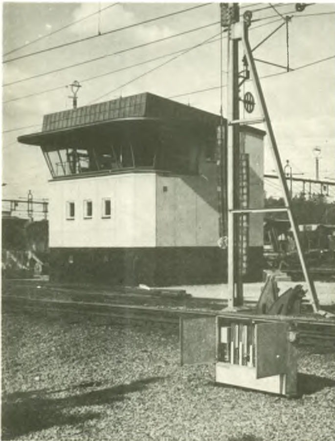
Kabelskåp och rangertorn, Tomtebodå.
