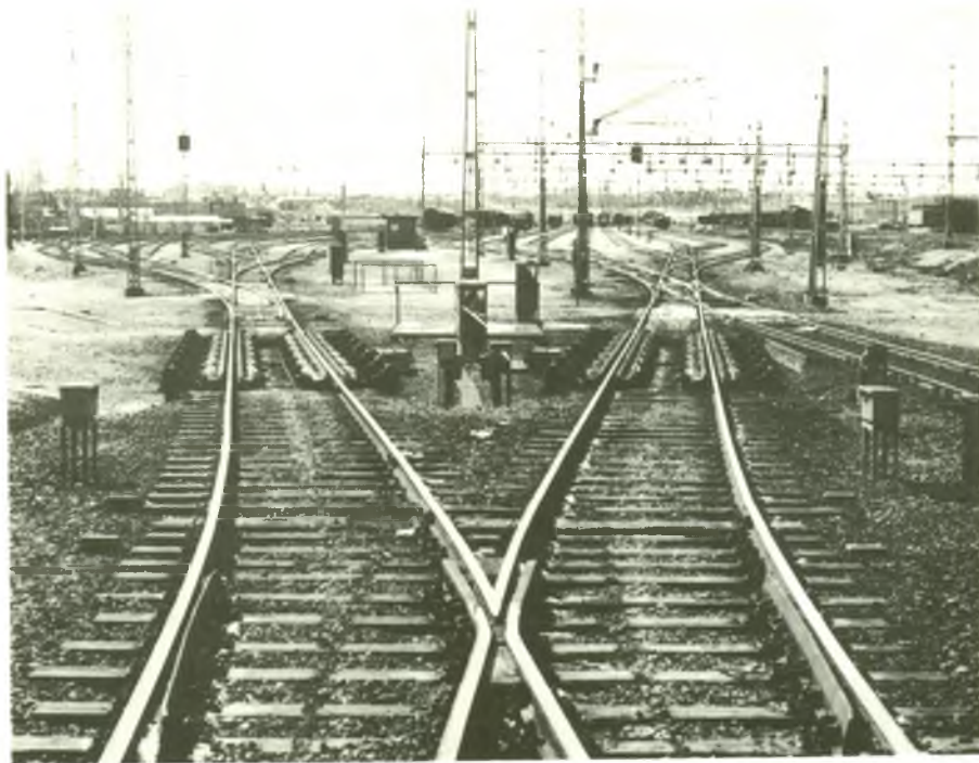
Dalbromsar (Westinghouse) med radarantenn för hastighetsstyrning typ "Westarc", Gävle.
