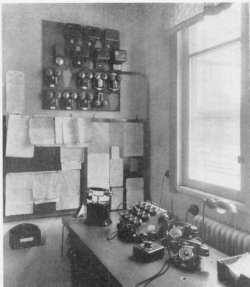
Fig. 15. Tågexpedition vid statens järnvägar. Till vänster på bordet kopplingslåda uppbyggd av 12 väggkontakter, till vänster på väggen de intagna etappledningarnas anropsorgan.
