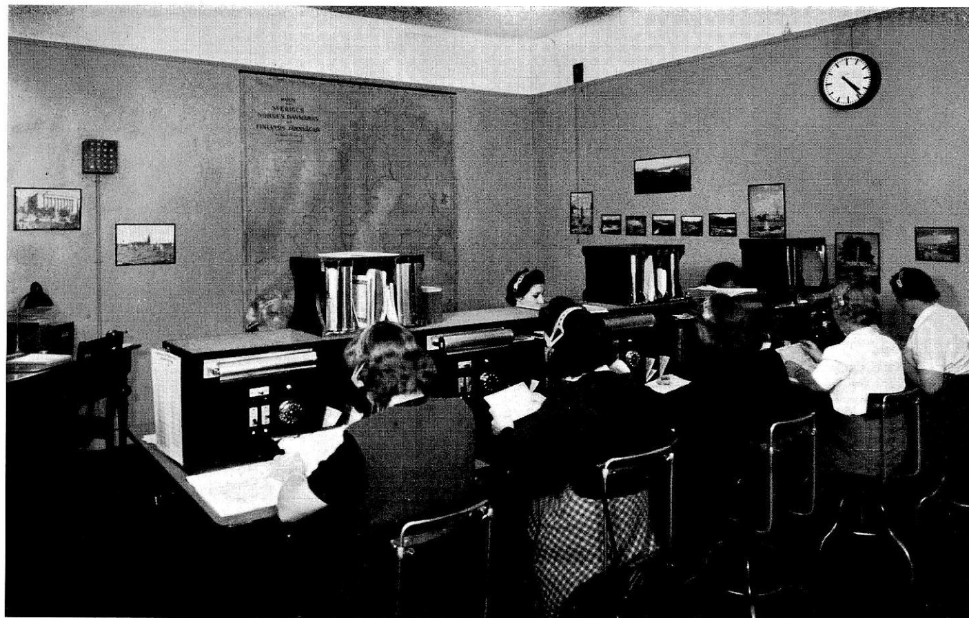
Fig. 39. Upplysningsexpeditionen vid Stockholm C. Bordsraden påbörjad i anslutning till installationen av den första automatiska abonnentväxeln men sedermera utökad. Bilden från år 1945.
